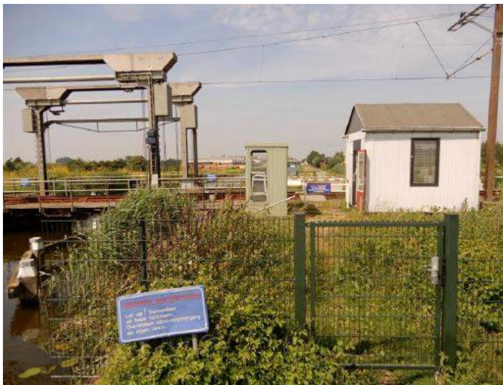
Afbeelding 353 – Overweg Bodegraven. Bron: Kees Rotteveel 2017
