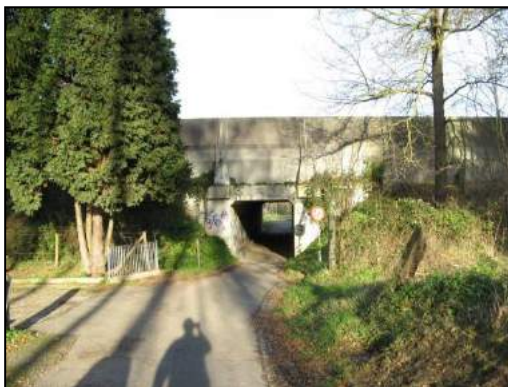
Afbeelding 98 – Tunnel onder de A76. Brakkender Gats. Bron: Han van der Voet
