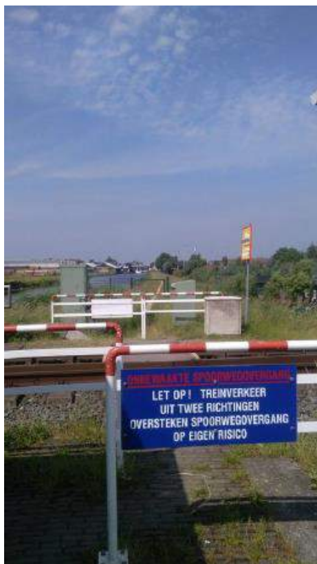
Afbeelding 355 – Overweg Bodegraven. Bron: Kees Rotteveel 2017
