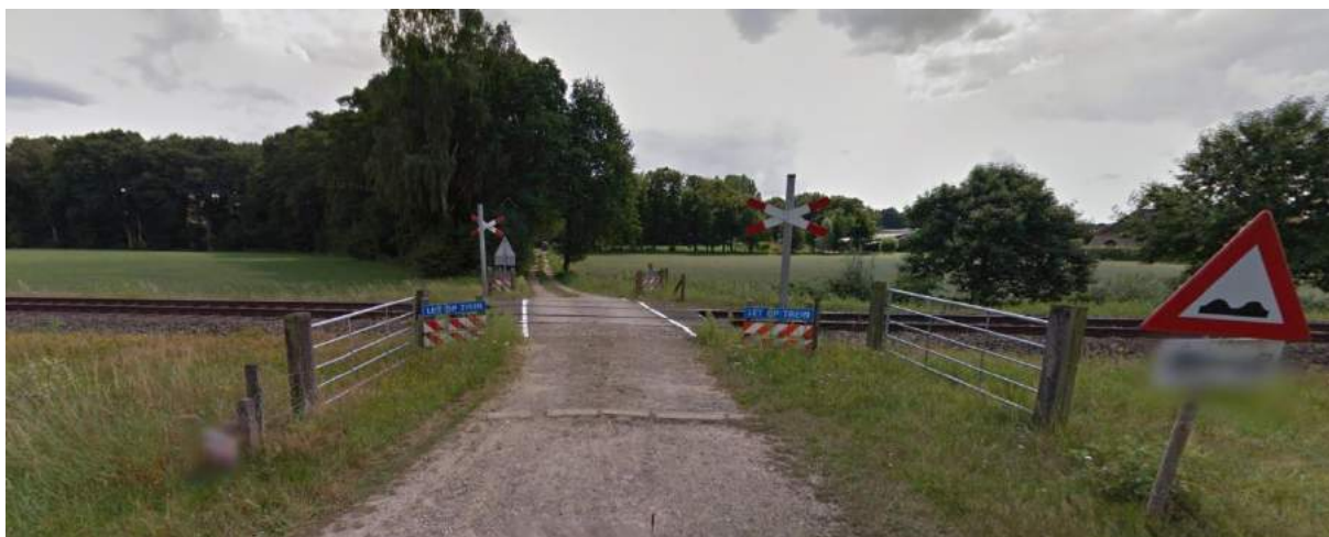
Afbeelding 166 – Hulzerdijk. Bron: Google StreetView 2017
